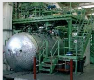
Заливка смолы в глубоком вакууме
